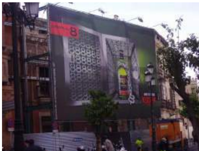
Foto 2. Fachada en rehabilitación de la Casa de la Moneda en Sevilla
