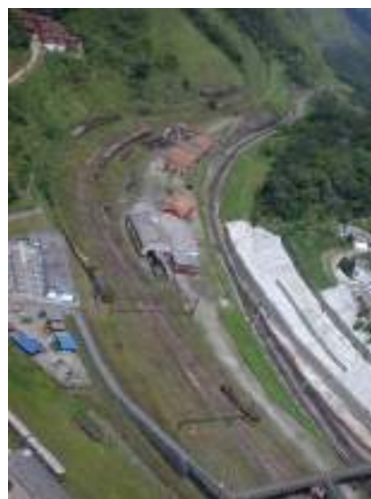
Foto 3.- Patio Ferroviário Ayuntamiento de Santo André, 2006
