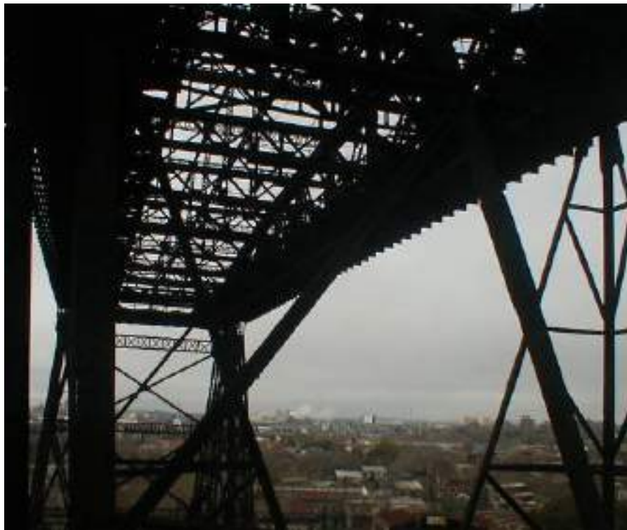
FOTO 3.- Vista desde el Puente Transbordador.
