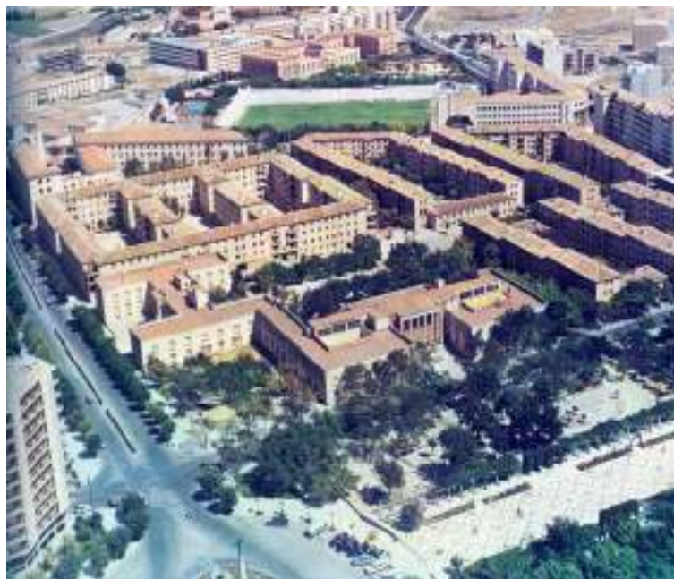
Foto 1.- Vista general del barrio de las Viviendas Protegidas de Jaén. En primer término se observa el interesante edificio del Hospital Materno-Infantil desaparecido a mediados de los años setenta del pasado siglo.
