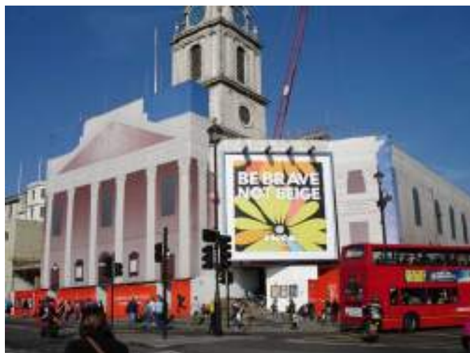
Foto 3. Fachada en rehabilitación de St. Martin in the Field en Londres
