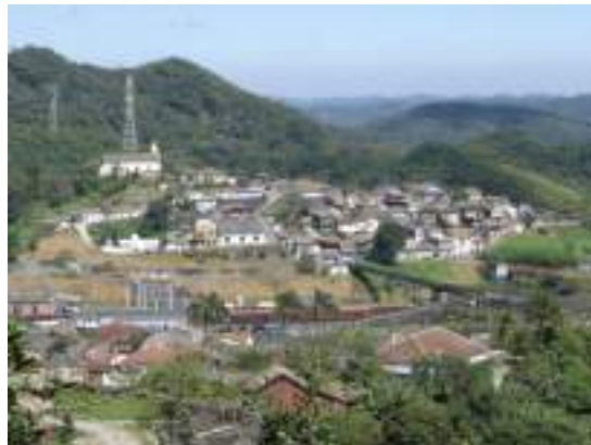
Foto 5.- Patio Ferroviário, Ayuntamiento de Santo André, 2006
