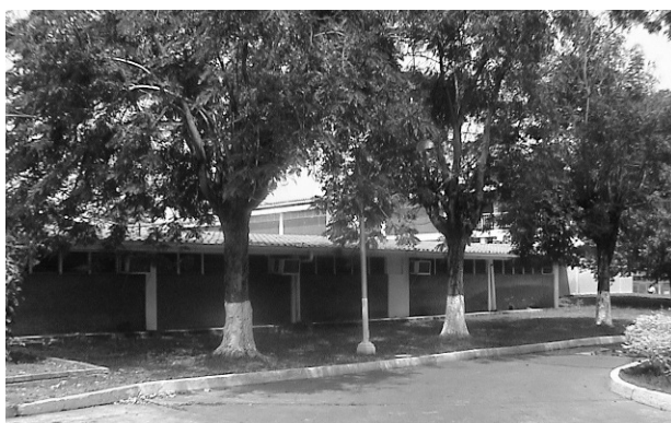
Hotel Aguas Calientes de Ureña, edificación construida en 1954
