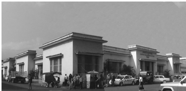
Salón de Lectura de Rubio, edificación construida en 1917.
