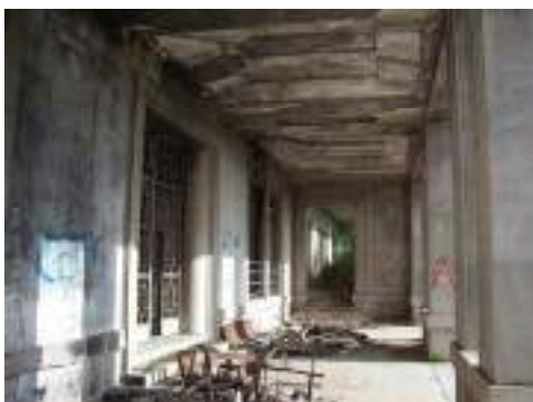
Figure 6, Vista sul portico
