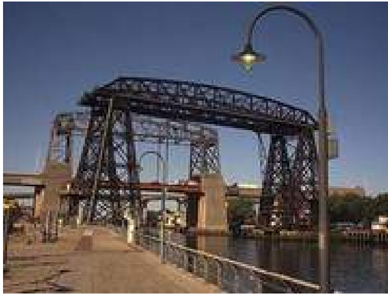
FOTO 2.- Puente Transbordador en la actualidad.-
