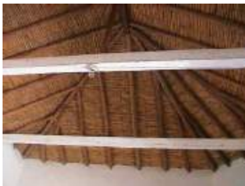
Foto 3.- Detalle de techo de una vivienda donde se puede observar el uso de caña brava y horcones de madera.
