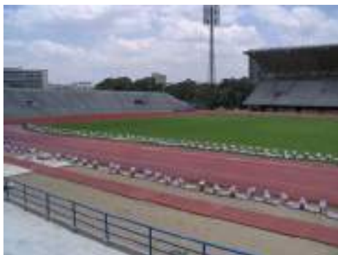
Foto N° 7. Estadio Olímpico antes de ser intervenido.
