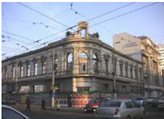
Foto 1.- Huellas de construcción en la zona de la Estación del Norte en Bucarest
