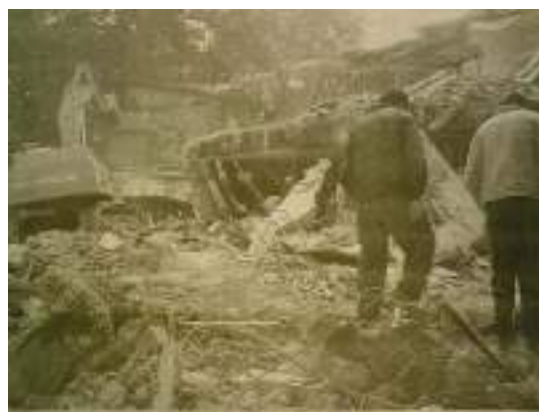
Foto 5. –Foto de la demolición del edificio – Periódico Tribuna de Minas – 24/07/2005
