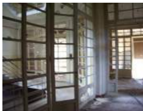
Figure 10 , Ballatoio di ingresso
