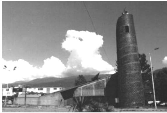
Iglesia Divino Redentor. La Unidad Vecinal, edificación construida en 1955.
