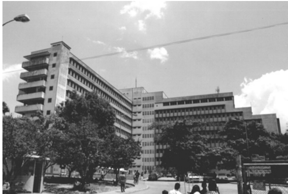
Hospital Central de San Cristóbal, edificación construida en 1958.
