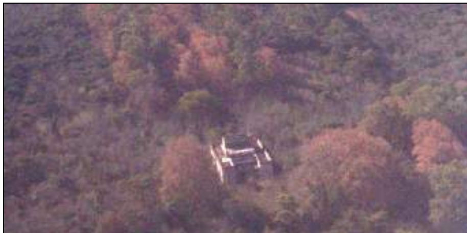
Actual fotografía del estado de Conservación del Casco de la Estancia
