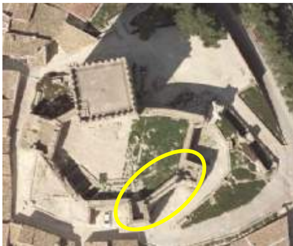
Fotos 1.- Vista aérea del castillo de Moratalla. Localización del lienzo de muralla comprendido entre la torre de la Magdalena y la torre del Mirador.
