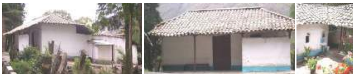
Figura 5: Respuesta de la vivienda en la que destaca la conformación formal compacta, el corredor externo y el patio central con corredores que unen los diferentes ambientes internos.
