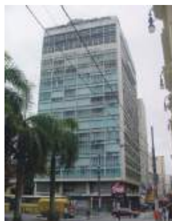
Foto 3. – Edifício Clube Juiz de Fora. (Archivo de los autores)
