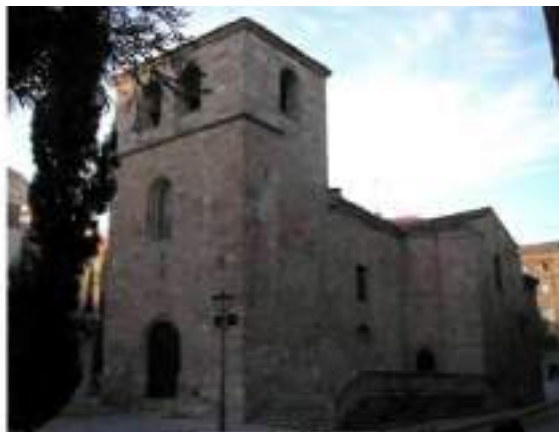
Detalle de la torre
