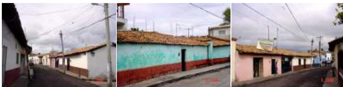
Figura 7 El aspecto formal de la vivienda se constituye a partir de los materiales y las técnicas de construcción. En el caso de viviendas con una crujía principal y solar, el aspecto de la fachada es de carácter cerrado hacia el exterior, predominando el macizo sobre el vano. Sin embargo, en el caso de las casas con patio central y corredores, presentan más vanos en la fachada, los cuales guardan casi siempre, u una proporción de 2 a 1, aunque se conserva el desarrollo de la vida hacia el interior.
