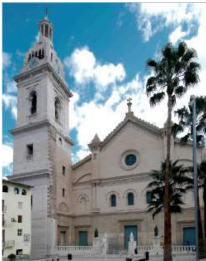
Foto 2.- Fachada principal de la Colegiata
