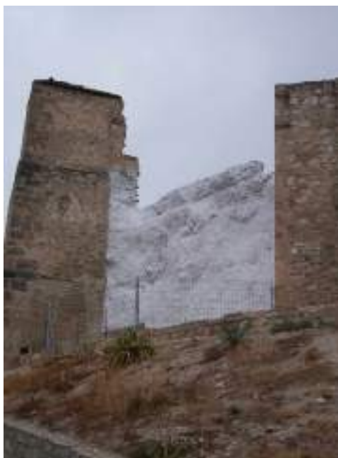
Fotos 7.- Lienzo de muralla entre la Torre de la Magdalena y la Torre del Mirador tras el tratamiento de consolidación con lechada de cal.
