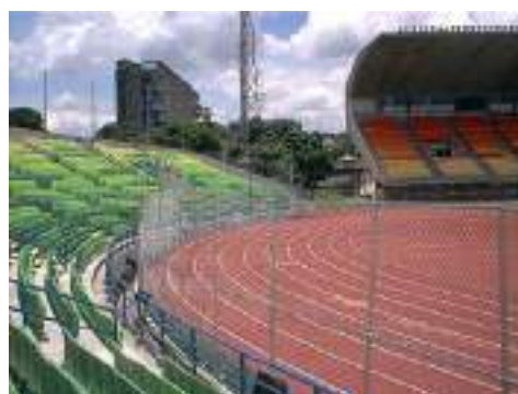
Foto N° 8. Estadio Olímpico después de la intervención.
