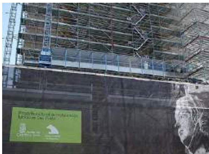
Foto 4. Fachada en rehabilitación de la iglesia de San Pablo en Valladolid
