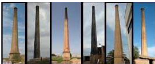
Chimeneas de Aldaia-Valencia
