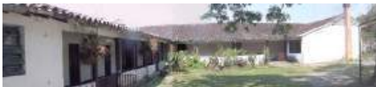
Figura 4.- Vista casa del patrón y patio interno
