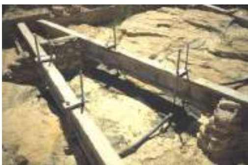
Figuras 10 y 11.- Sistema de sujeción ideado para sustituir a las pletinas oxidadas. Barón Cano y Gómez de Terreros.
