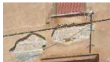
Figure 3, mancanza di intonaco
