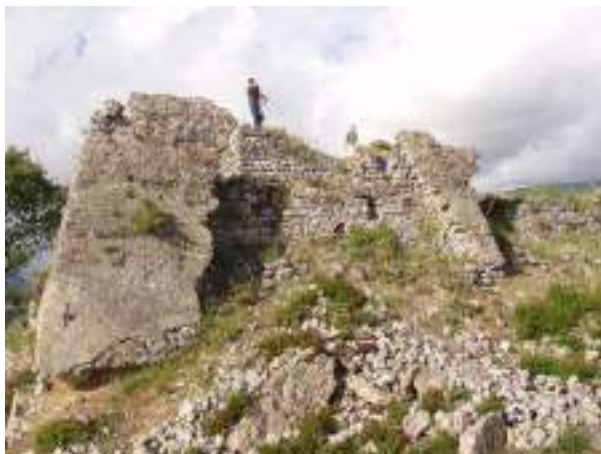
Fotografía 5.- Restos del castillo de La Molpa realizado con argamasa y piedra caliza aparejada
