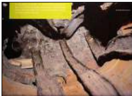
Foto 3. Panel expuesto en la restauración del Giraldillo en las Atarazanas, en el que se muestra el interior con la inclusión del refuerzo de duelas de bronce, 1998
