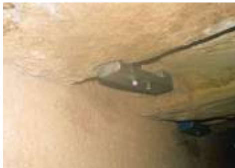
Figuras 10 y 11.- Sistema de sujeción ideado para sustituir a las pletinas oxidadas. Barón Cano y Gómez de Terreros.
