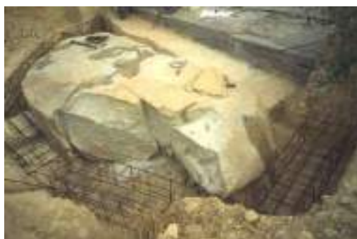
Figuras 12 y 13.- Ejecución de zunchado perimetral de la gran losa y relleno superior de la galería del Dólmen. Barón Cano.
