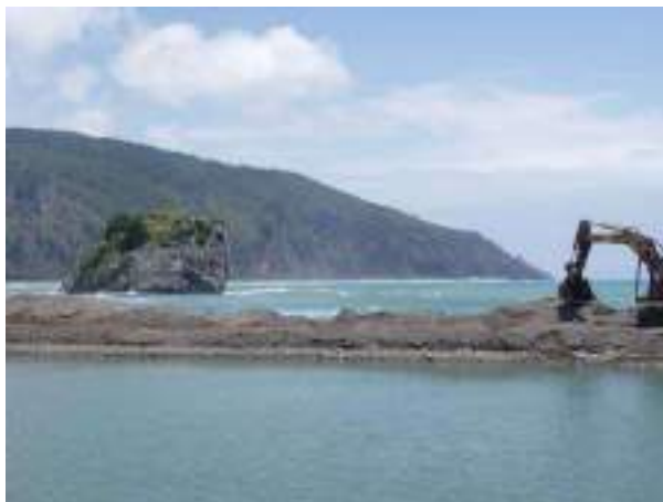
Fotografía 3.- Dragado de la desembocadura del río Mingardo
