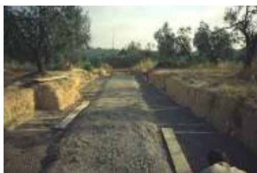
Figuras 12 y 13.- Ejecución de zunchado perimetral de la gran losa y relleno superior de la galería del Dólmen. Barón Cano.
