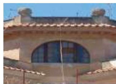
Figure 5, dilavamenti sul muretto d'attico
