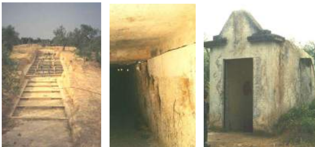
Figuras 7, 8 y 9.- Aspecto superior y vista desde el interior de la estructura diseñada para sustitución de las losas desaparecidas y casamata de acceso al dolmen. Barón Cano y Gómez de Terreros.
