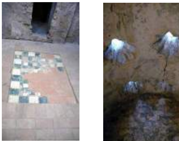
Fotos 5 y 6. Restos de azulejería en el baño almohade y tragaluces estrellados en las bóvedas.
